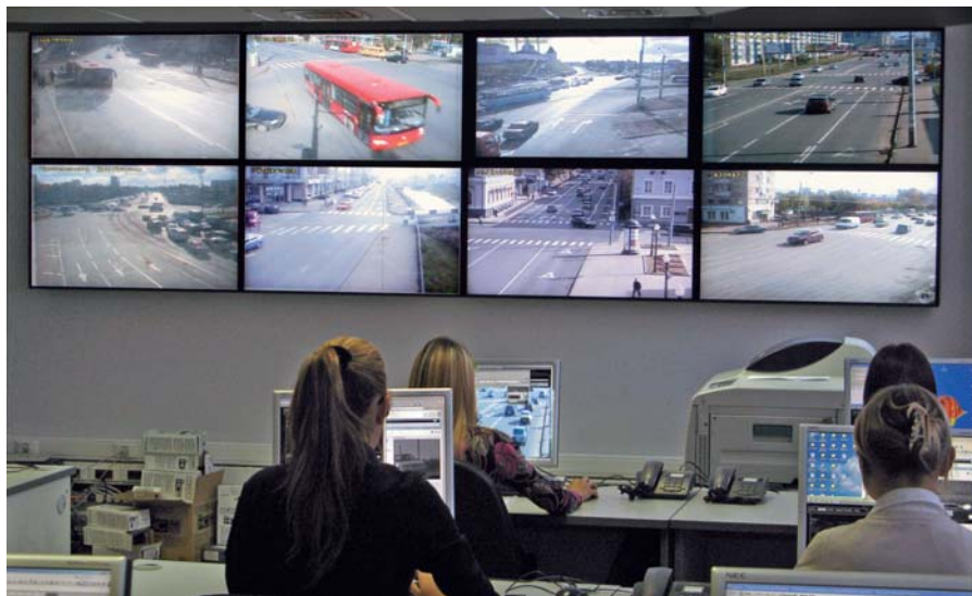
Г. Казань. Центр обработки данных видеофиксации нарушений правил дорожного движения Управления ГИБДД МВД Республики Татарстан
